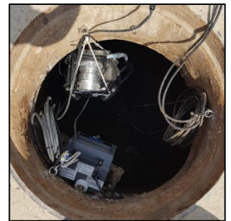
Im Schacht installiertes Probenahmemodul in der Ex-Version
